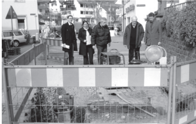
Die Stadtwerke verlegen derzeit neue Leitungen in der Kleingemünder Straße. Galeristin Angela Mahmoud sowie (v. r.) Uwe Kellermann (Stadtwerke), Gerhard Wagner (HWE), Harald Apfel (Stadtwerke) und Matthias Friedrich (HWE) besichtigen die Baustelle. Foto: Welker
