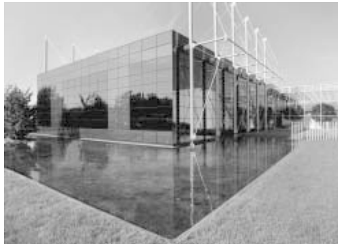
Photovoltaik kann auch schön sein: Die Solarstromanlage am Betriebsgebäude der Firma Lamy. Foto: Rothe
