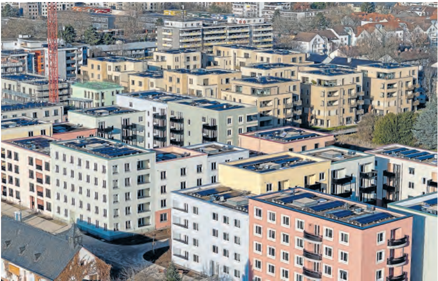
Im Hospital-Quartier in Heidelberg Rohrbach liefern Photovoltaikanlagen direkt vor Ort erzeugte Energie an die Mieterinnen und Mieter.
