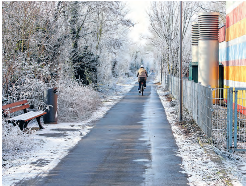
Strecken, die für den Radverkehr wichtig sind, wie der Heinrich-Menger-Weg im Pfaffengrund, werden bevorzugt erneuert. (Foto Stadt Heidelberg)
