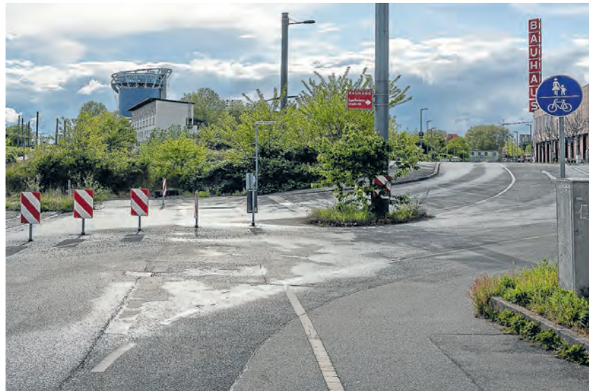
Der Höhenunterschied auf Höhe des Bauhauses (Kamelbuckel) wird mit einer Bodenauffüllung ausgeglichen. (Foto Buck)
