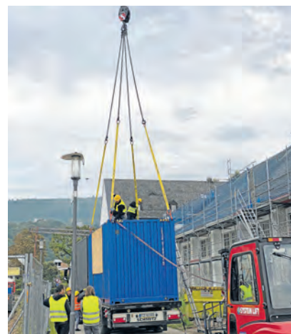
Die Container kommen an der Beachhalle an (Foto Stadt Heidelberg)
