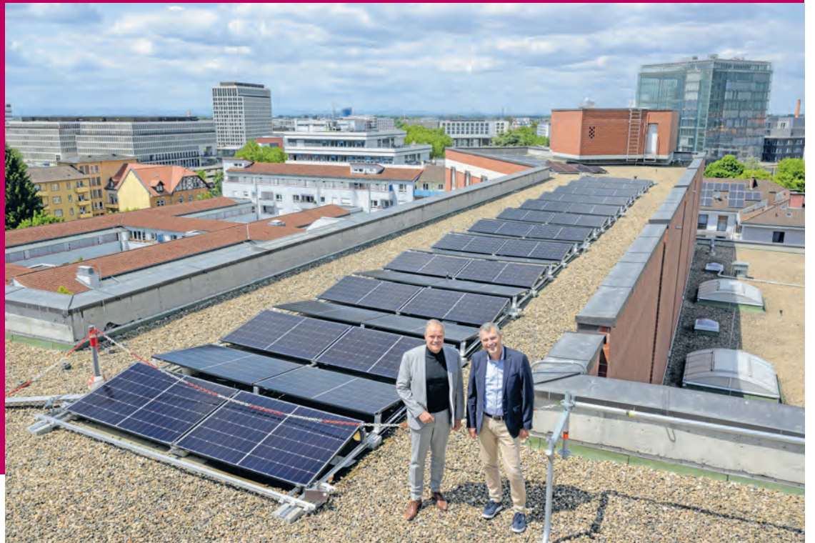
Oberbürgermeister Eckart Würzner (l.) und Klaus Pawlowski, Geschäftsführer der Agentur für Arbeit Heidelberg, freuen sich über die neuen Photovoltaik-Anlagen auf dem Dach der Agentur für Arbeit. (Foto Rothe)
