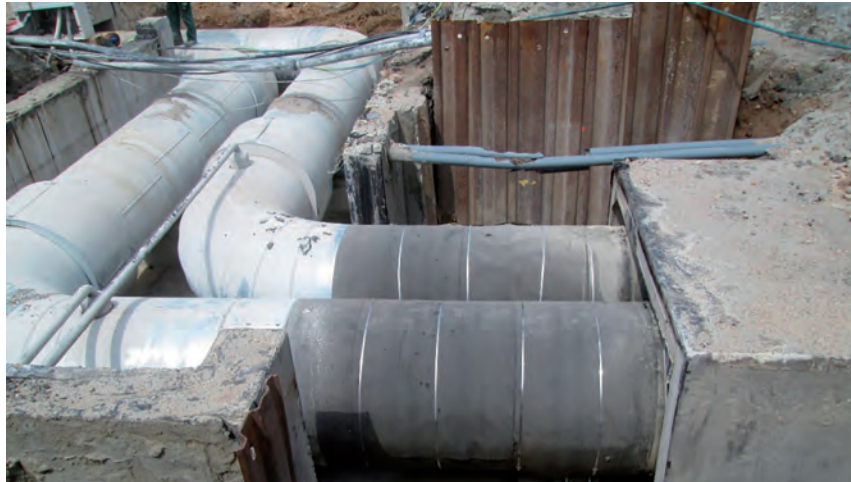
Fernwärme-Kompensatoren: Ab April 2025 werden in der Eppelheimer Straße acht davon erneuert.
