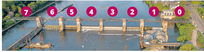
Dieses Jahr werden die Stege über den Kraftwerkskanal und die Wehrfelder 1 bis 4 erneuert. (Foto WSV.de)
