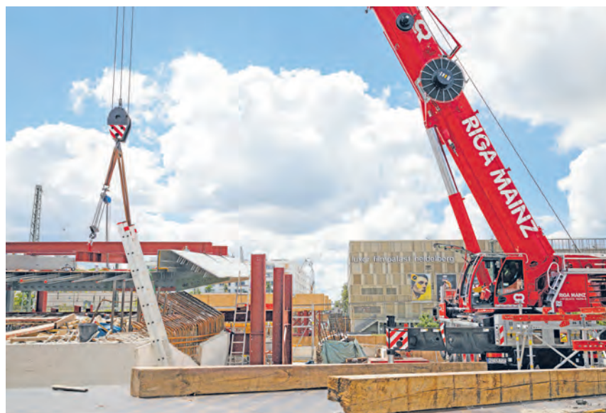
Die ersten Brückenelemente sitzen auf der neuen Gneisenaubrücke. (Foto Stadt HD)
