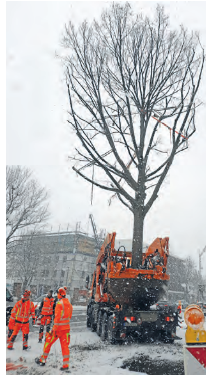
Bei der Pflanzung kam eine der größten hydraulischen Spatenmaschinen Deutschlands zum Einsatz (Foto Stadt HD)
