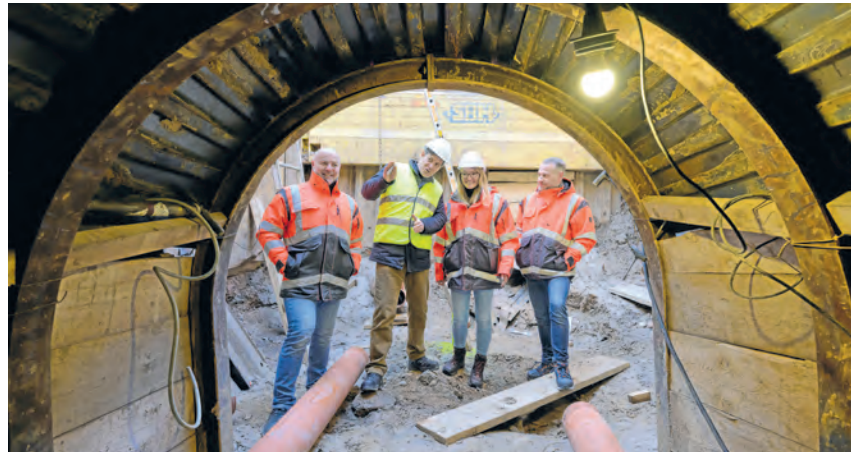
Erster Bürgermeister Jürgen Odszuck (2.v.l.) besichtigte mit (v.l.) Stefan Ziemer, Nora Wolber und Markus Kusche vom Tiefbauamt den Stollen. (Foto Rothe)
