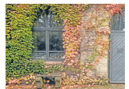
Fassade kostenlos begrünen (Foto Firma Huben)
