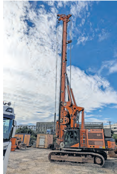
Ein 24 Meter großes Drehbohrgerät setzt derzeit Vertiefungen für die Befestigung der Gneisenaubücke. (Foto Stadt HD)
