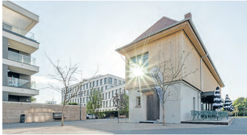
Eins der zehn ausgezeichneten Projekte für „Beispielhaftes Bauen“: Das Stellwerk 08 in der Bahnhofstadt beherbergt nach seinem Umbau ein beliebtes Café. (Foto Shakabra)
