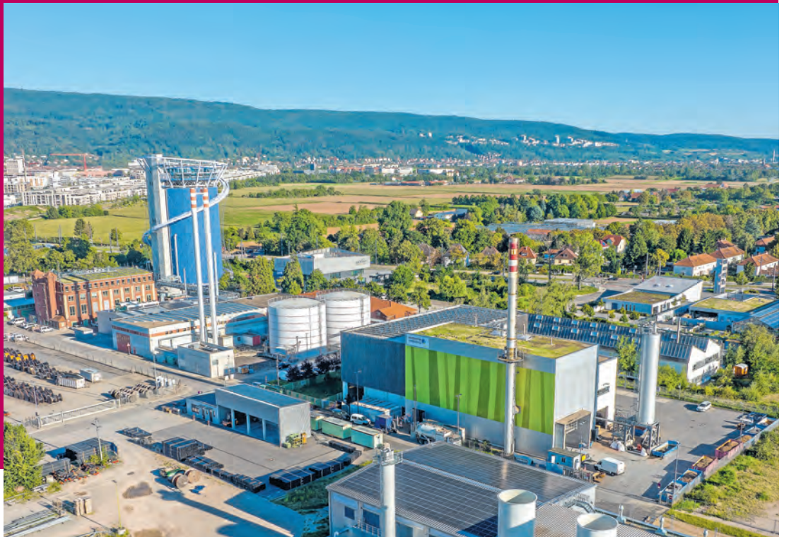
ENERGIEpark Pfaffengrund der Stadtwerke Heidelberg: ein zentraler Ort für die Wärmewende in Heidelberg. Hier kann Energie gespeichert werden, bis sie gebraucht wird. (Foto Dittmer/Stadtwerke Heidelberg)
