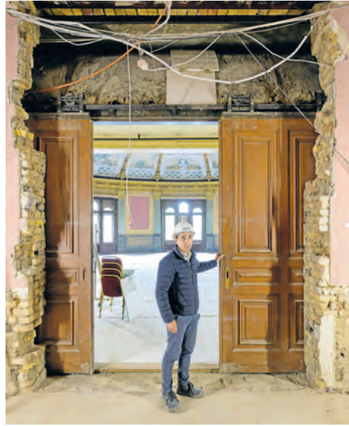
Projektleiter Sebastian Streckel zeigt eine kürzlich freigelegte historische Schiebetür. (Foto Rothe)
