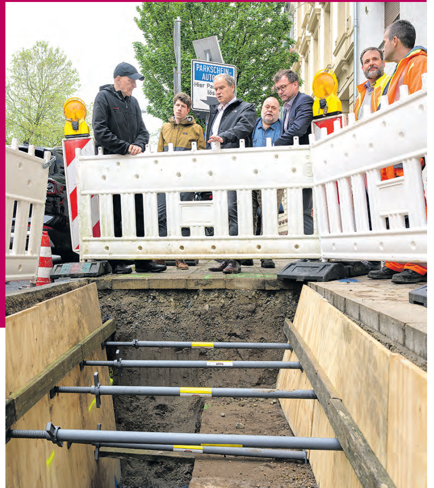
Eine enge Sache: Wegen vieler Leitungen gibt es oft kaum Platz für Baumwurzeln, erklärten die Mitarbeiter des Landschaftsamtes bei einem Besuch des Oberbürgermeisters. (Foto Rothe)
