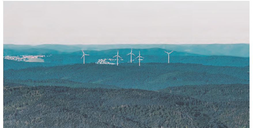
Am Greiner Eck drehen sich die Windräder bereits. Nicht weit von hier hat das Land eine weitere Fläche zur Produktion von Windenergie ausgeschrieben. (Foto Venus)
