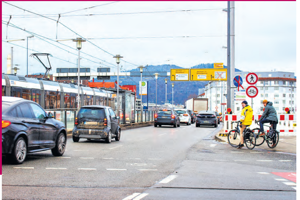
Die Montpellierbrücke wird zum Nadelöhr. Die Autostraße stadteinwärts wird einspurig; Radfahrende können den Radweg auf der gegenüberliegenden Straßenseite nutzen. (Foto Stadt HD)
