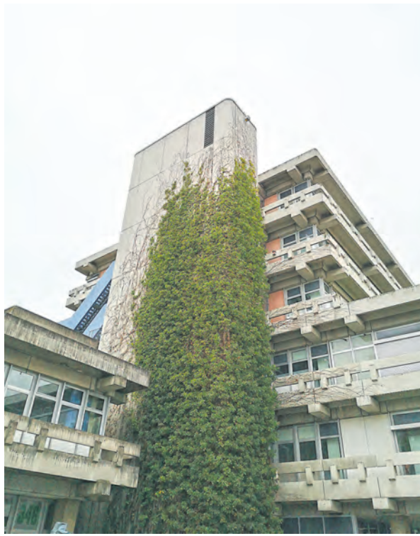
Fassadenbegrünung – eine wirkungsvolle und gleichzeitig aufwandsarme Form der Stadtbegrünung und Klimafolgenabmilderung (Foto Wetzels)
