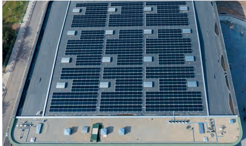
Sauberer Solarstrom vom Dach der Großsporthalle im Heidelberg Innovation Park (hip). Die PV-Anlage erzeugt jährlich rund 300.000 Kilowattstunden Solarstrom und damit den Strombedarf von 125 Haushalten. Die CO 2 -Emissionen reduzieren sich pro Jahr um 142 Tonnen.
