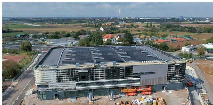
Die neue PV-Anlage auf der Großsporthalle wird jährlich rund 300.000 kWh Solarstrom erzeugen – das entspricht dem Bedarf von 125 Haushalten.
