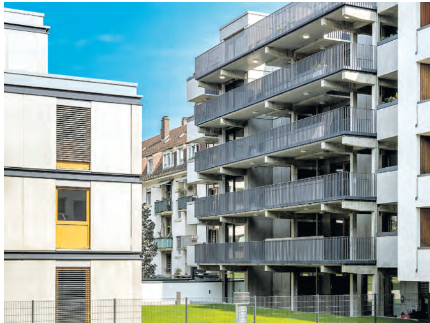
38 barrierefreie Mietwohnungen für Senioren baute die städtische Wohnungsbaugesellschaft GGH in der Bluntschlistraße in Bergheim. (Foto GGH/Buck)
