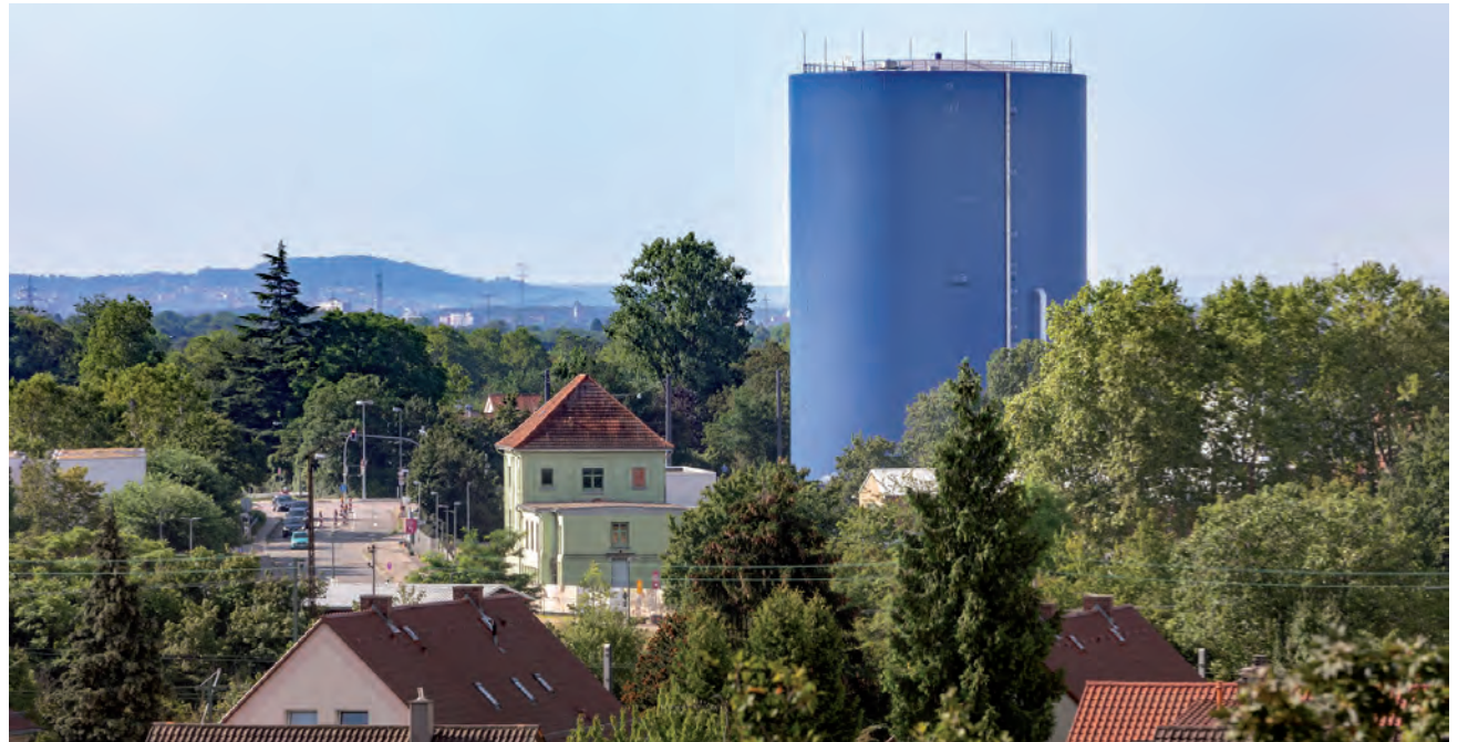
In den letzten Monaten wurden viele Arbeiten am Energie- und Zukunftsspeicher im Inneren des Technikraums vorangebracht.
