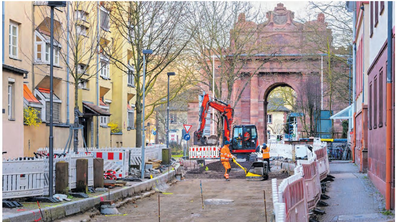
Unter der Hauptstraße Ost liegen jetzt auf einer Länge von 440 Metern neue Versorgungsleitungen und Abwasserrohre. Der Kanal war mehr als 100 Jahre alt und musste dringend erneuert werden. (Foto Rothe)
