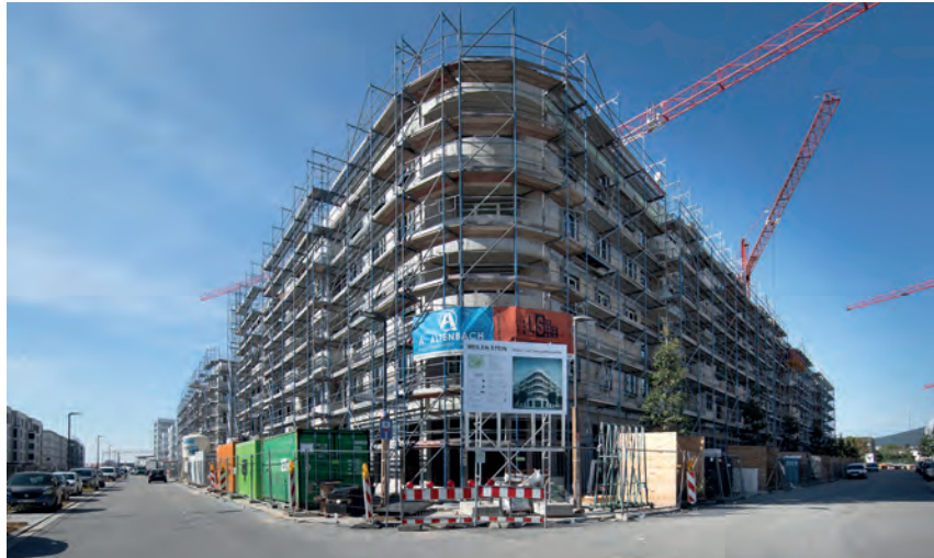
Das MEILEN.STEIN-Quartier in der Bauphase Spätsommer 2018
