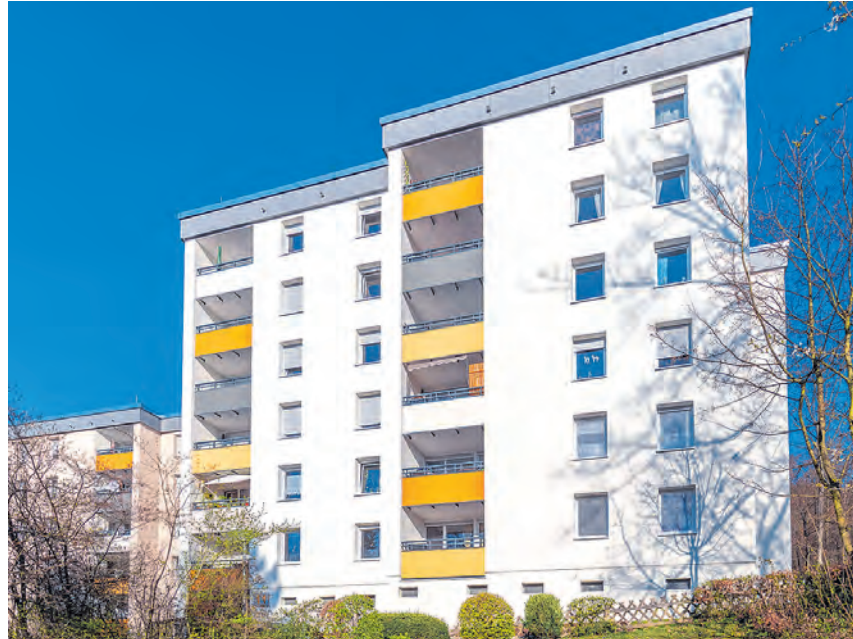
Die GGH investiert viel Geld in den Erhalt des Wohnungsbestands. Auf dem Boxberg wurden beispielsweise 558 Wohnungen energetisch saniert. (Foto GGH/Buck)
