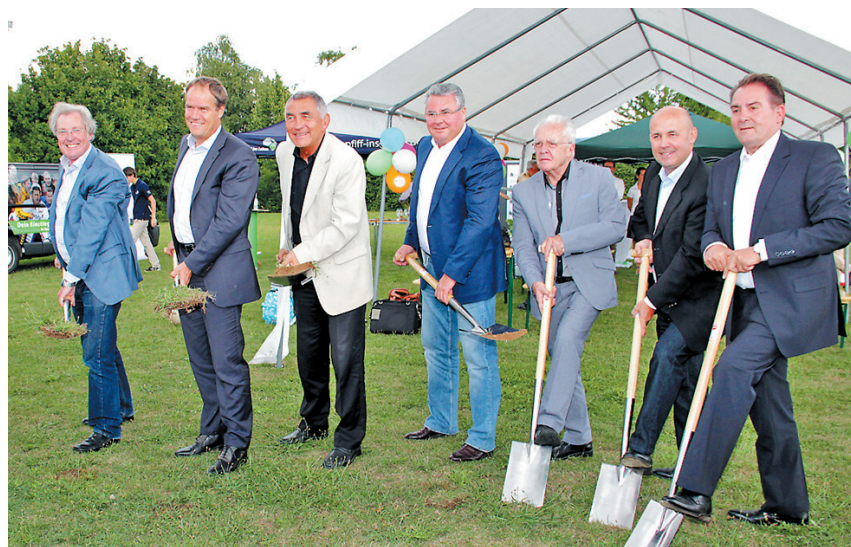
Spatenstich für das neue Fußballförderzentrum in Kirchheim Foto: Anpiff ins Leben
