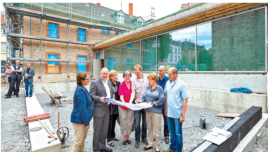
Erster Bürgermeister Bernd Stadel (2.v.l.) informiert sich über den Baufortschritt beim Bürgerzentrum Neuenheim.
