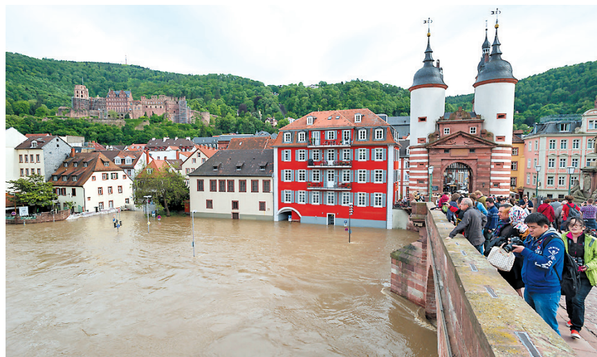
„Hochwasser-Tourismus“ auf der Alten Brücke am vergangenen Wochenende Foto: Rothe
