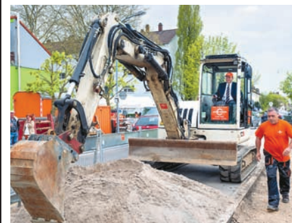
Baubürgermeister Bernd Stadel beim symbolischen „Spatenstich“
