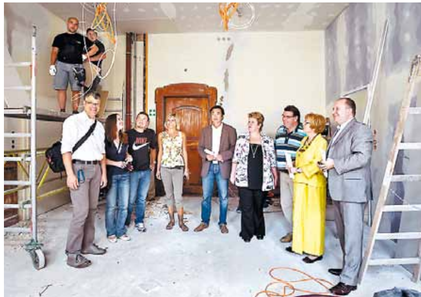
▲ Begehung des Hölderlin-Gymnasiums während der Sanierungsarbeiten mit dem Ersten Bürgermeister Bernd Stadel (r.).
