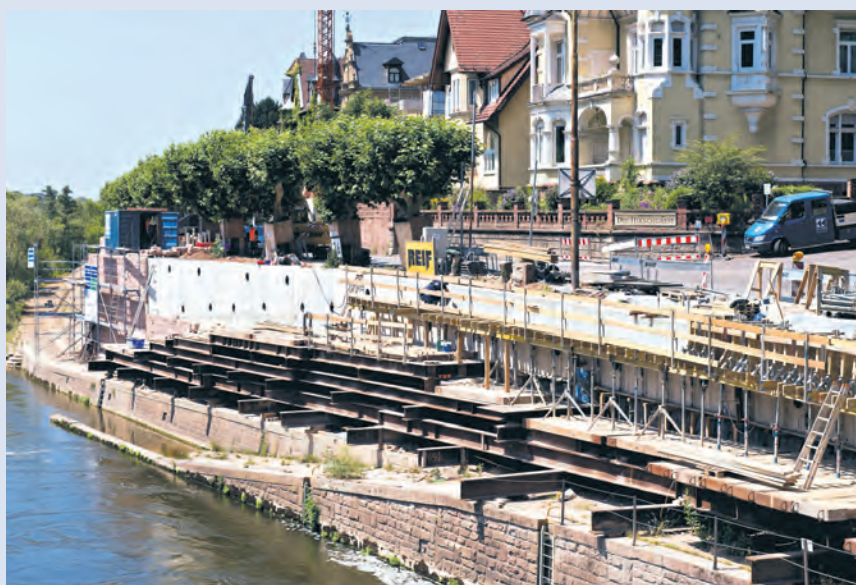
Eine aufwendige Stützmauer schafft Platz für Geh- und Radweg am Ufer. Foto: Rothe
