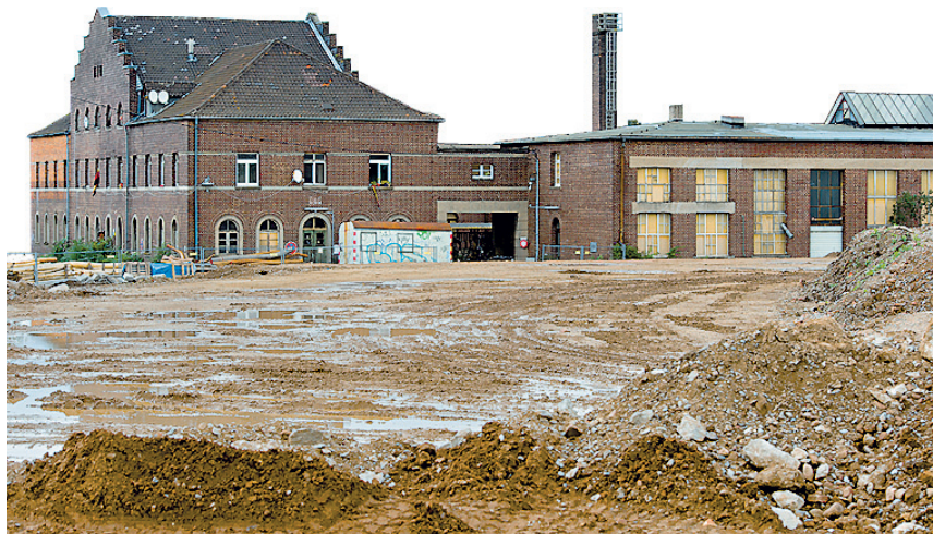
Das Bahnbetriebswerk im Ochsenkopf: Eine erste Instandsetzung würde rund 2,7 Millionen Euro kosten.
