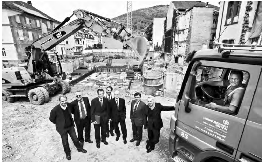
Der Theaterrohbau wächst mit Unterstützung von HeidelbergCement: Vorstandsvorsitzender Bernd Scheifele (3.v.l.) mit Vertretern der Theater- und Orchesterstiftung, des Bürgerkomitees, des Architekturbüros Waechter+ Waechter, der Gesellschaft für Grund- und Hausbesitz sowie Intendant Peter Spubler. Foto: Rothe
