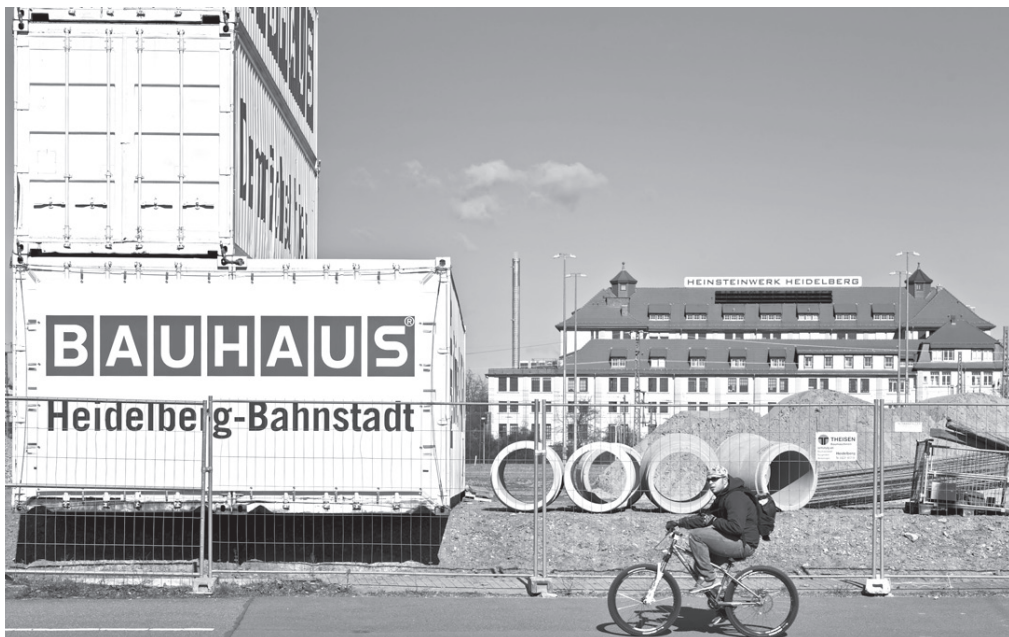
„Bauhaus“ zieht in die Bahnstadt. Das Unternehmen errichtet zwischen der Eppelheimer Straße und den Bahngleisen einen Baumarkt. Im Hintergrund ist das Heinsteinwerk zu erkennen. Foto: Rothe
