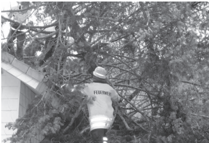
Mitarbeiter der Feuerwehr und der Stadtwerke beim Freilegen der Versorgungsleitung
