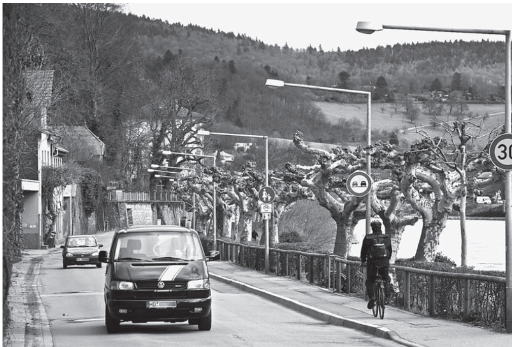
Sanierungsbedürftig: die Neuenheimer und Ziegelhäuser Landstraße
