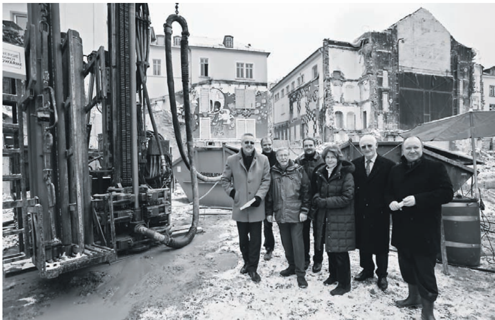
Auf der Theater-Baustelle informierten sich Erster Bürgermeister Bernd Stadel, Architekt Felix Waechter und Vertreter des Großsponsors HeidelbergCement über den Stand der Arbeiten. Baustoffe von Heidelberg Cement werden bei der Geothermiebohrung und beim anschließenden Hochbau eingesetzt. Foto: Rothe
