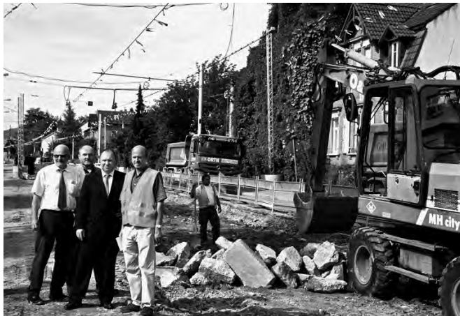
Erster Bürgermeister Bernd Stadel (2. v. r.) überzeugte sich bei einem Baustellenbesuch vom Fortgang der Arbeiten. Foto: Rothe
