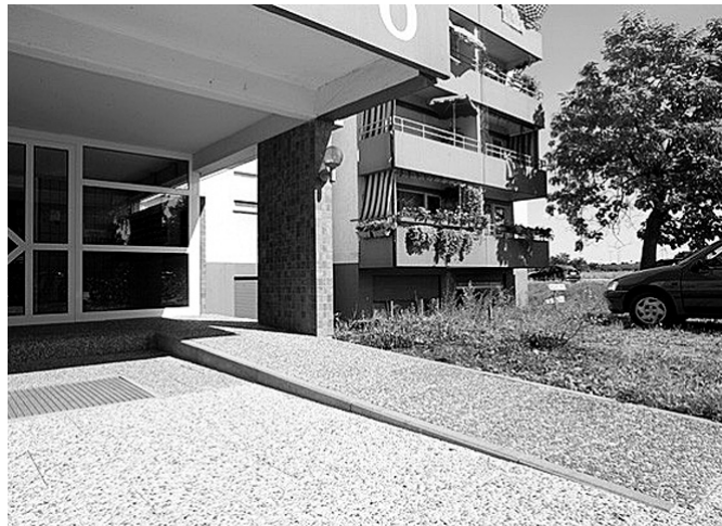
Stufenloser Zugang zu einem Mehrfamilienhaus nach Sanierung im Sandwingert Foto: IBV
