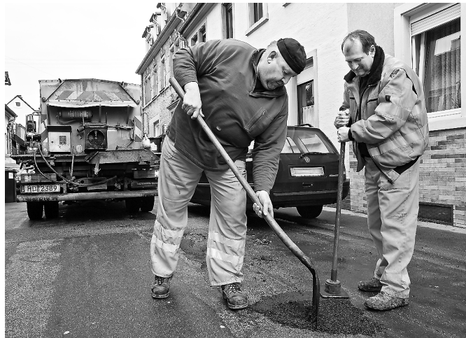
Die städtischen Mitarbeiter Dietmar Bader und Wolfgang Schell (v. l.) bessern Frostschäden an Straßen aus. Foto: Rothe
