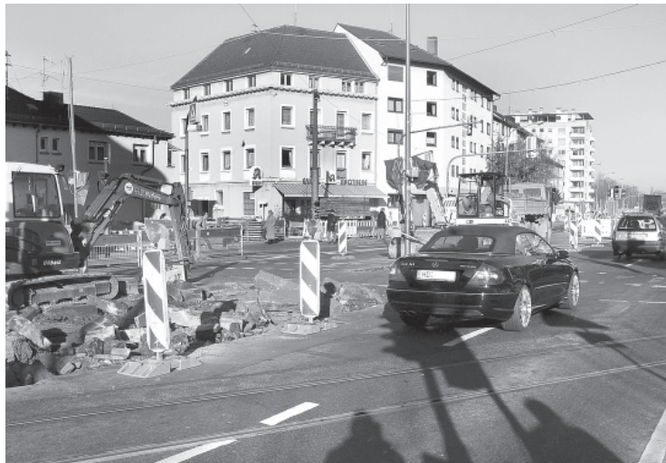
Baustelle Römerstraße in Höhe Rohrbach Markt Foto: Stadt Heidelberg
