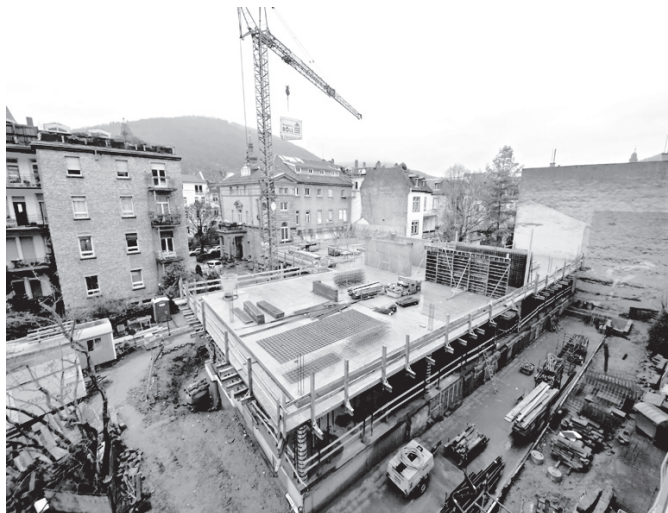
Halbzeit auf der Baustelle in der Landfriedstraße: Die Hochschule für Jüdische Studien feierte Richtfest für das neue Haus, das sie am 1. Oktober beziehen will.
