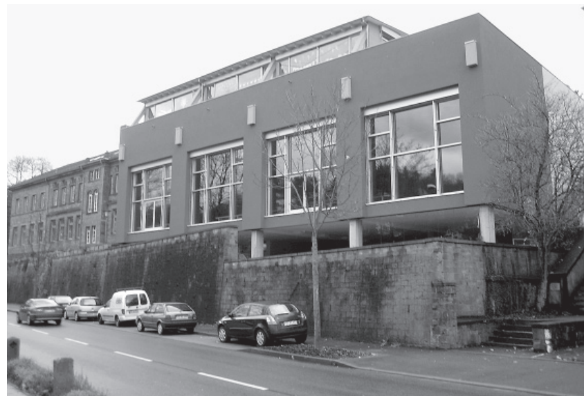
... mit lichtdurchlässigen Glasflächen versehen und energetisch optimiert. Schon 2003 ließ die Stadt vier Klassenzimmer auf der Halle errichten. Fotos: Stadt Heidelberg
