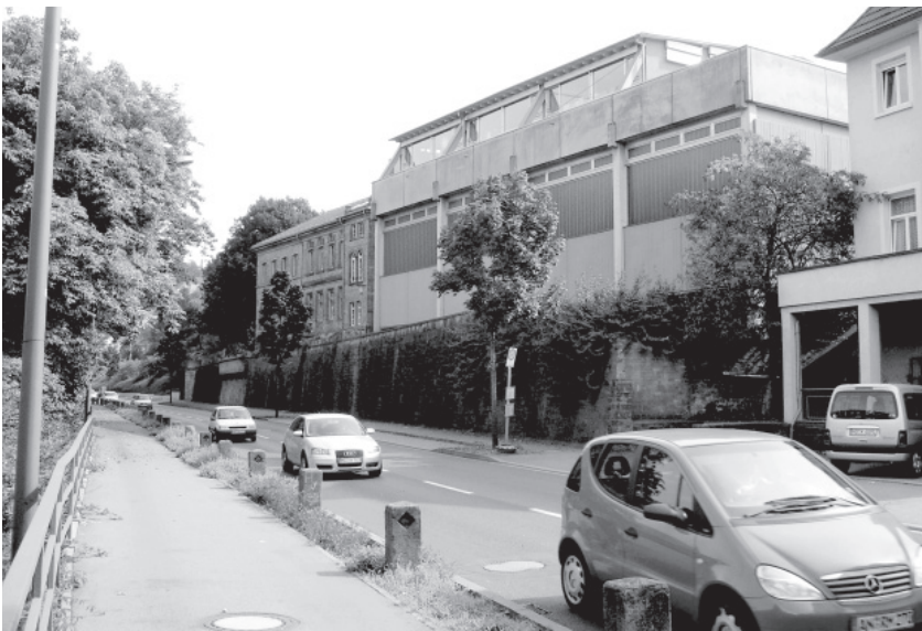
Schulstandort Heidelberg: Die Sanierung der Turnhalle der Schlierbachschule wurde Frühjahr 2008 beendet. Das Betongebäude aus den 70-er Jahren wurde unter anderem...
