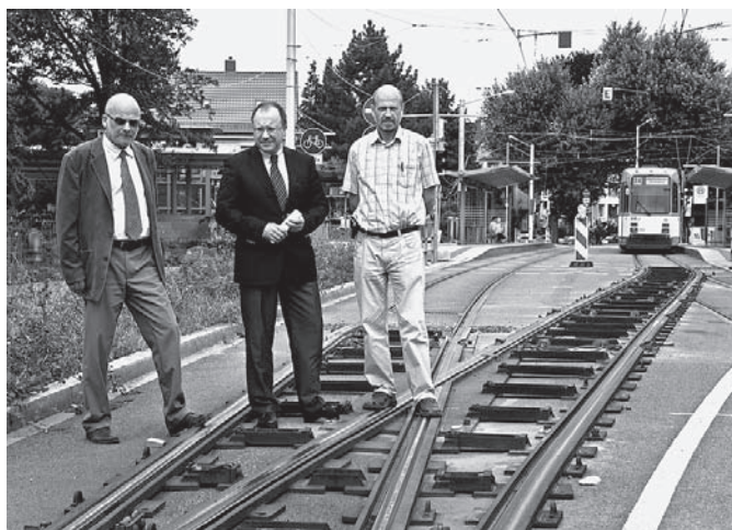
Eine technische Besonderheit zeigen Jürgen Weber vom Tiefbauamt (l.) und Bauoberleiter Heinrich Leuker (r.) dem Ersten Bürgermeister Bernd Stadel: eine auf den Asphalt aufgelegte „Kletterweiche“ zum Umsetzen der Straßenbahnen an der provisorischen Endstelle S-Bahnhof Weststadt/Südstadt. Foto: Rothe
