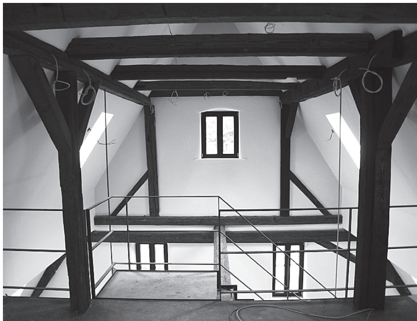
Ehemalige Leitzsch Mühle in Schlierbach
