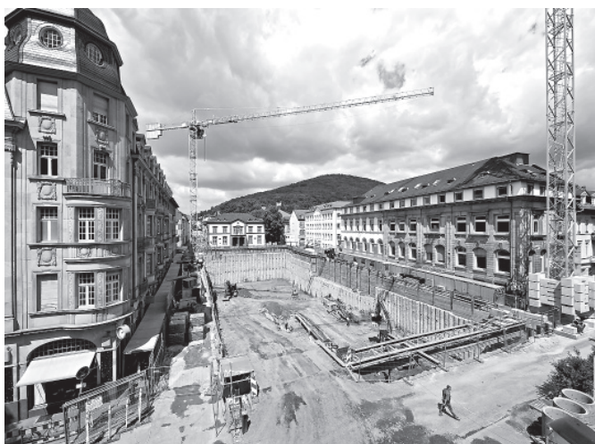
Noch wird ausgebaggert, aber bald beginnen die Arbeiten für den Rohbau der Tiefgarage. Die Kräne stehen schon. Foto: Rothe
