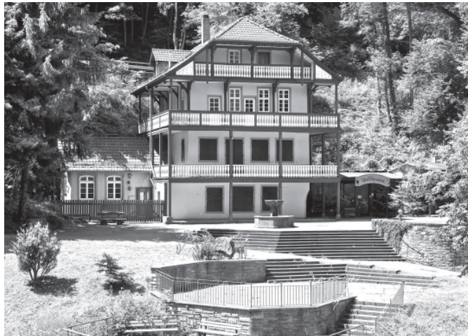
Die historische Gaststätte „Wolfsbrunnen“ wird saniert und im nächsten Jahr wieder Gäste anlocken. Foto: Rothe
