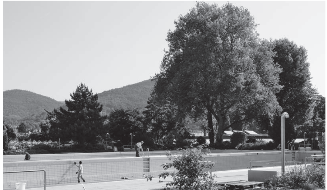
Feinschliff im Thermalbad. Die letzten Arbeiten vor der fristgerechten Wiedereröffnung.
