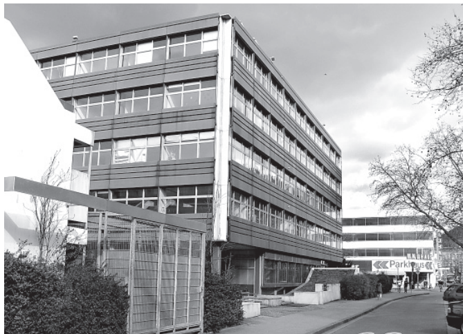
Auf dem Gelände des früheren Finanzamtes soll das neue Justizzentrum entstehen. Foto: Stadt Heidelberg
