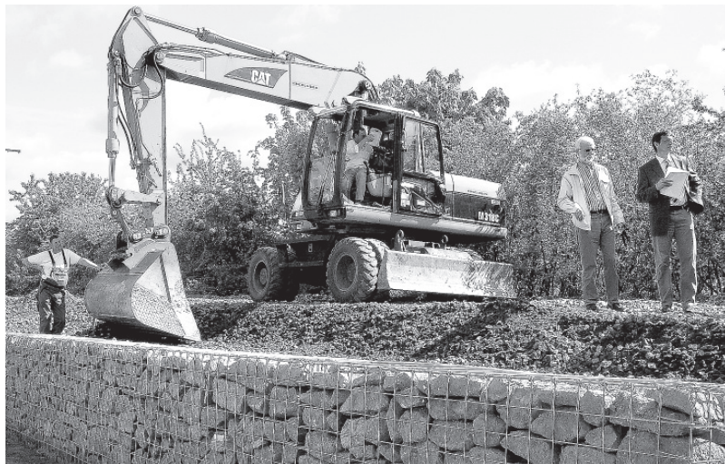
Trockenmauern, sandige Böden, Schotterflächen und sonnige Plätze entstehen zurzeit entlang der Hardtstraße für die „Bahnstadt-Eidechsen“. Foto: Stadt Heidelberg
