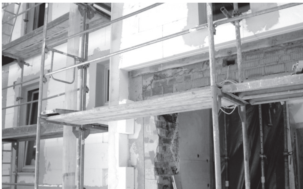
Effizienter Klimaschutz durch Dämmung der Außenwände
