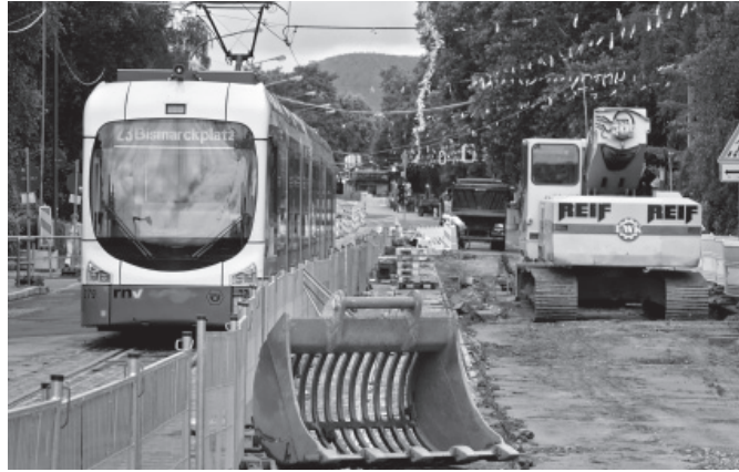
Die Firma Reif hat mit den Arbeiten zur Erneuerung der Rohrbacher Straße zügig begonnen. Foto: Rothe
