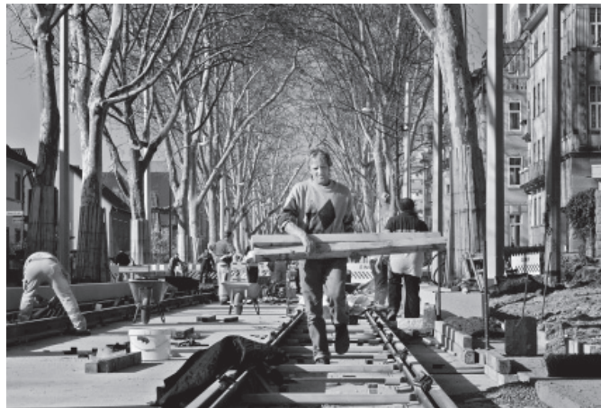
Die Gleiserneuerung auf der B 3 kommt gut voran. Foto: Rothe
